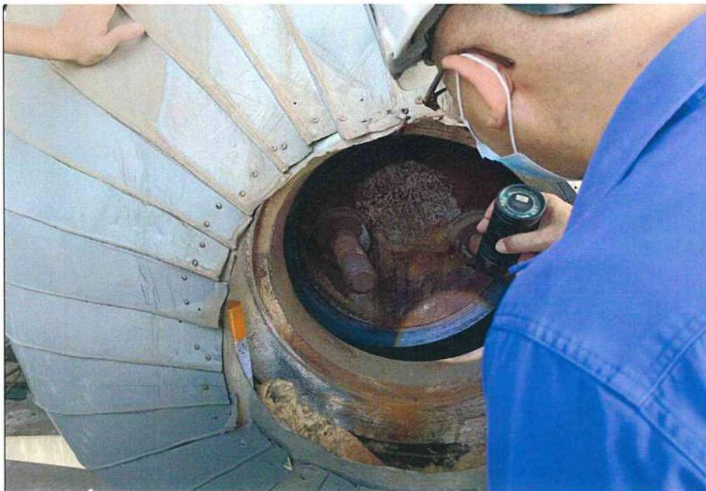
ตรวจสภาพ Steam Drum( Drum Internal)
