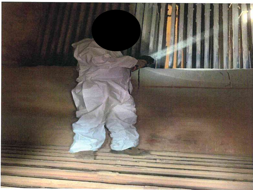
ตรวจ Secondary Superheater
